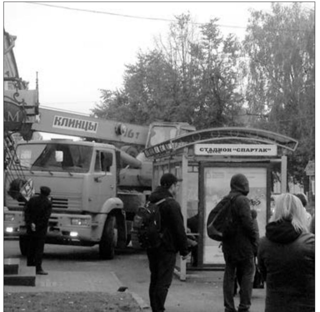
На пр. 25-го Октября появятся 10 современных автобусных павильонов с wi-fi и устройствами для подзарядки телефонов
